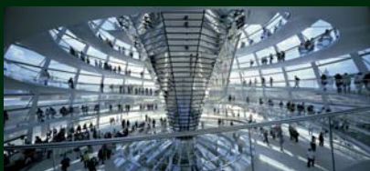
Integrated energy strategy, natural ventilation, energy generation: Foster + Partners' Reichstag Parliament, Berlin 創始主義，自然通風系統，以及整合能源的設計 Foster + Partners 設計的德國國會大廈
